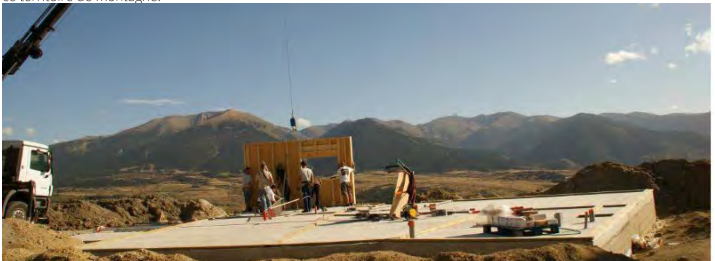
Construction de chalet à Font-Romeu
