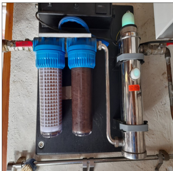
Photos du générateur d'UV présent au refuge
