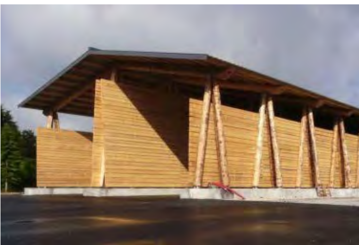
Hangar de stockage
