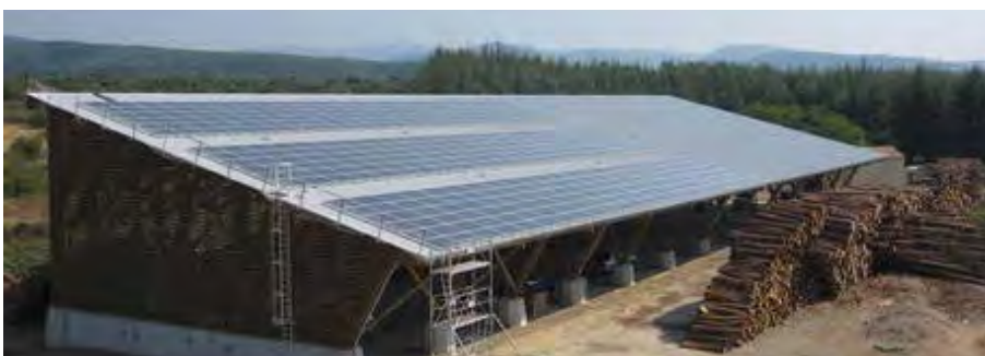
Mix énergétique : stockage bois et photovoltaïque
