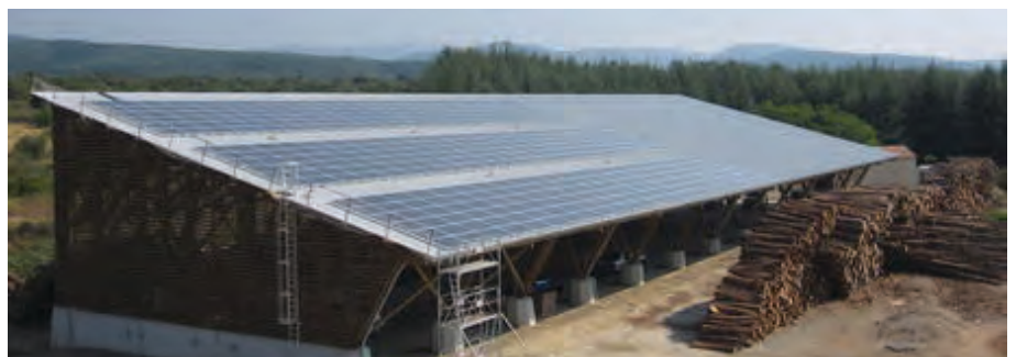
Mix énergétique : stockage bois et photovoltaïque
