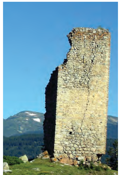
Lancer des campagnes de restauration et de valorisation des chemins et du petit patrimoine vernaculaire : La Tour de Creu
