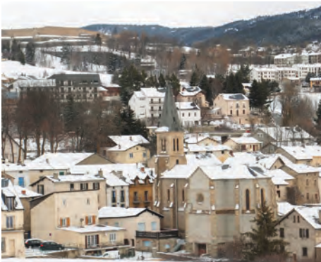
Une opération d'envergure pour la rénovation du bâti
