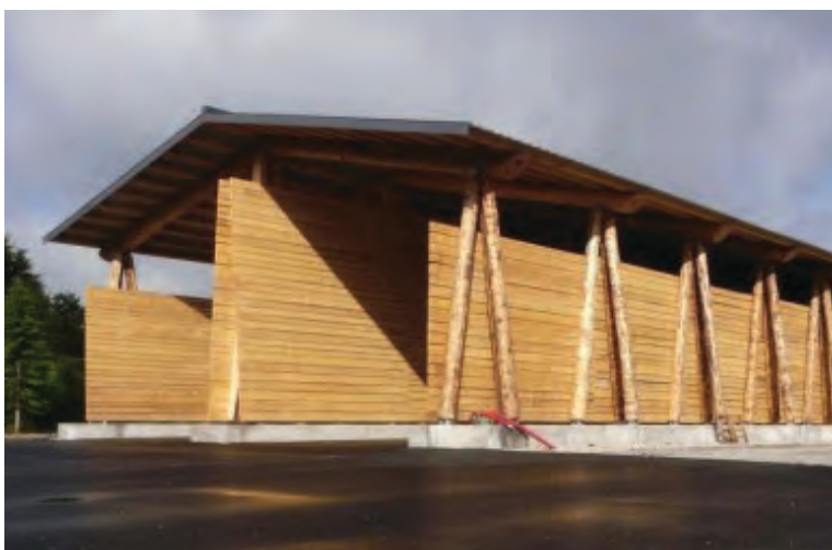
Hangar de stockage
