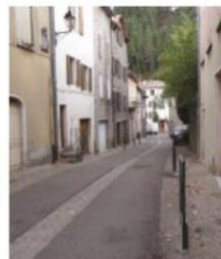
Caniveau central et trottoirs de niveau en pierre
