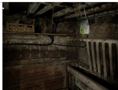
Sous-sol - Râteliers et mobiliers
