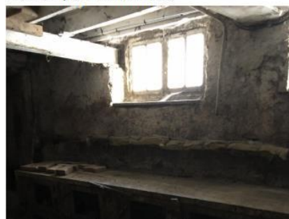
Sous-sol - ouvertures cour voisines
