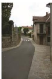
Ruelle de niveau, délimitation des rives par un revêtement différencié (dallage de pierre)
