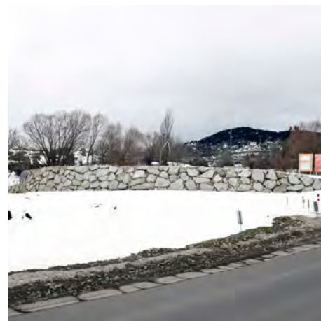
La zone d'activité de Font-Romeu met en oeuvre des terrassements importants, soutenus par des murets voulant rappeler les murets de pierres sèches traditionnels mais dont la taille est beaucoup trop importante.
