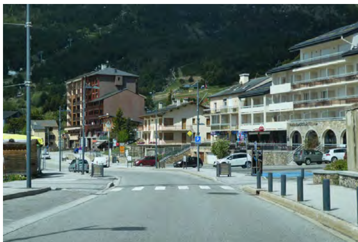
La rénovation des espaces publics en pied d'immeuble a permis d'améliorer considérablement l'image et le fonctionnement du pied de piste des Angles
