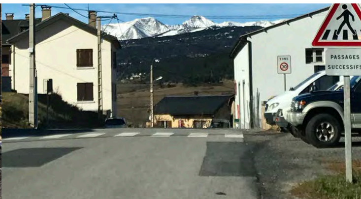
Réseau secondaire de voirie, commune de Saint-Pierre-dels-Forcats
