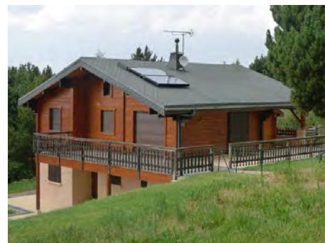
Panneaux solaires en toiture
