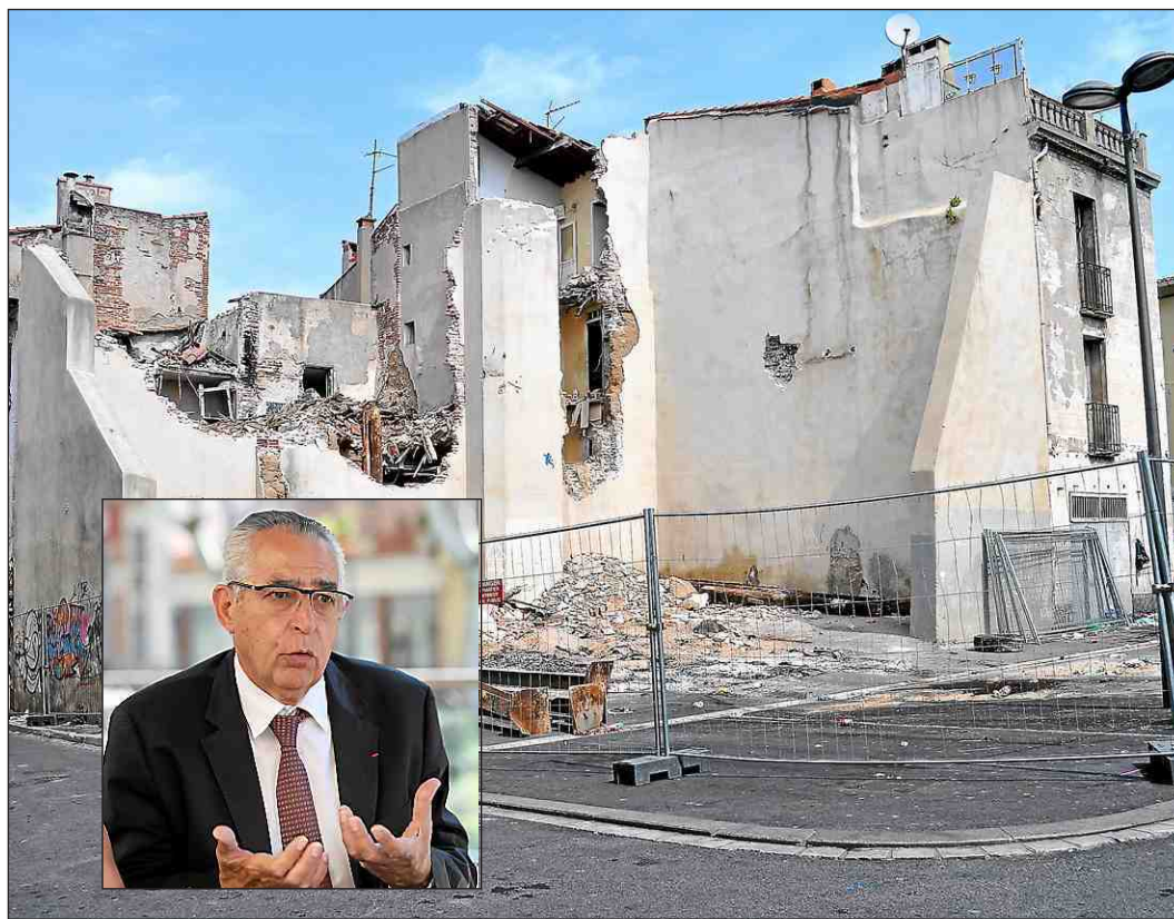
► Jean-Marc Pujol milite pour une reprise du chantier de l'îlot Puig.
